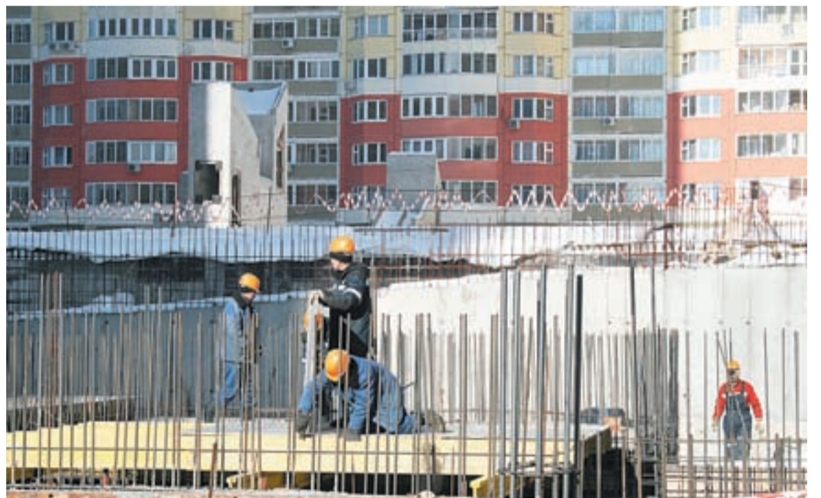
Строительство подземного гаража идет полным ходом
