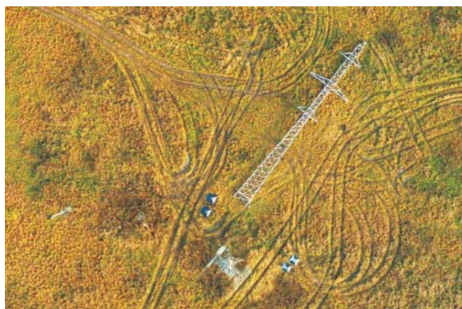
Рис. 3. Контроль выполнения работ по замене опор ВЛ
