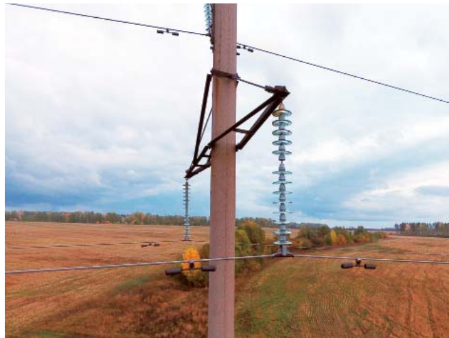
Рис. 6. Верховой осмотр ВЛ с помощью квадрокоптера DJI Phantom 4
